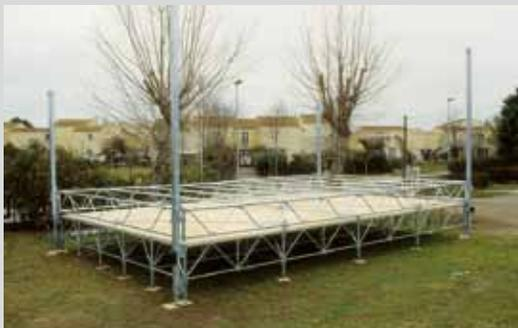
3 - Les éléments constitutifs sont assemblés au niveau du podium. Le montage de la toiture se fait à hauteur d'homme.
