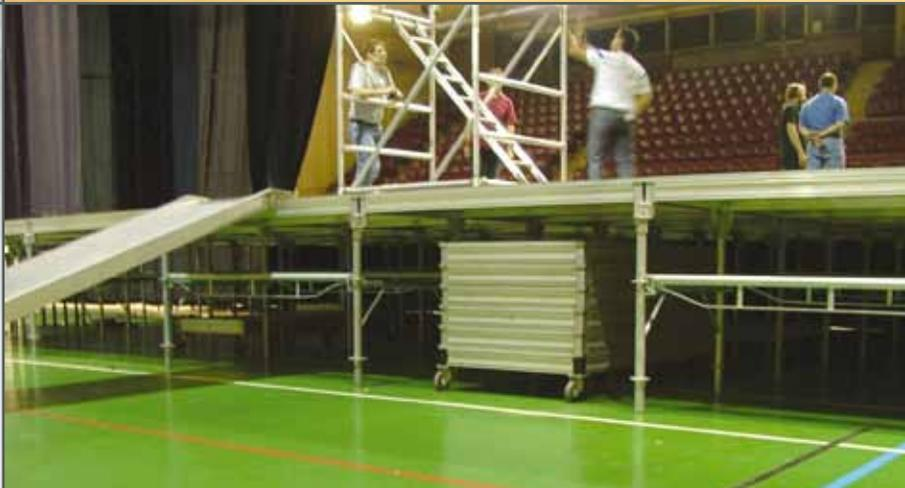
Stockage des podiums sous les ponts du multidirectionnel.
