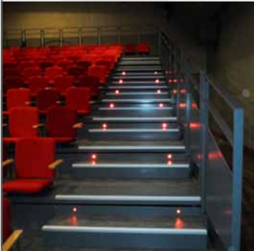
LED intégrées en contremarche
