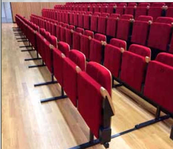
Poutres au sol devant la tribune
