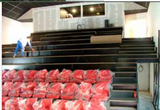
Tribune fixe en cours de montage
