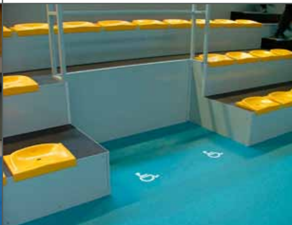
Aménagement d'un emplacement PMR
