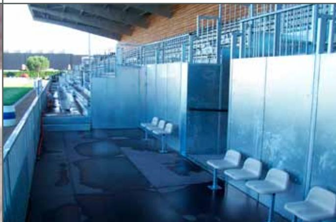
Plateforme PMR surelevée avec planchers antidérapants et sièges accompagnants
